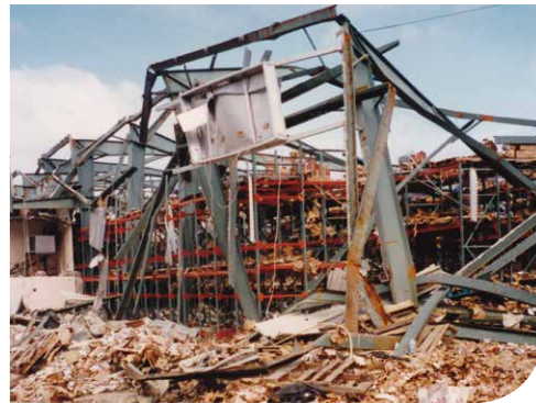
Gebouw van een bij NN verzekerde groothandel totaal vernield.
