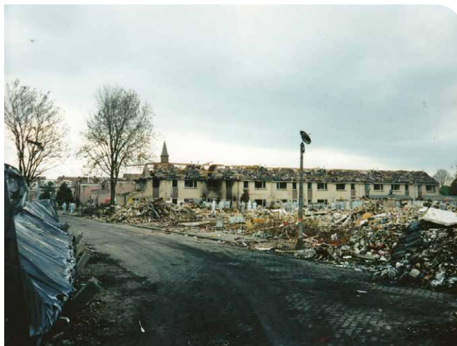
Huizen en auto's massaal total loss na de geëxplodeerde vuurwerkopslag in Enschede (FOTO TD-NN).
